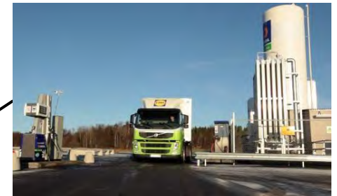
LNG Fuelling Station in Stockholm
