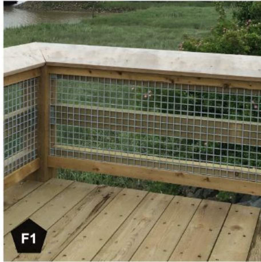
F1 TIMBER GUARDRAIL
